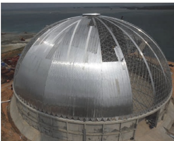
Slika 7. Alumijska kupola za skladištenje ugljena
