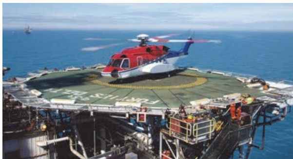
Slika 10. Platforme za helikoptere
