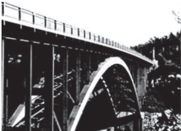
Slika 11. Most Arvida u Quebecu, Kanada
