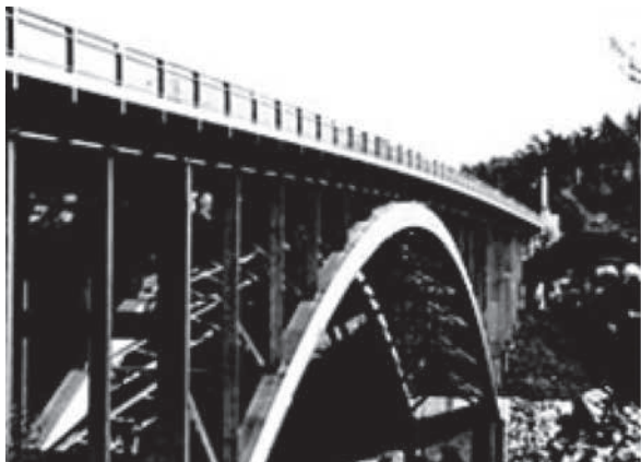
Slika 11. Most Arvida u Quebecu, Kanada
