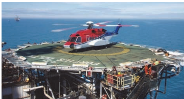
Slika 10. Platforme za helikoptere
