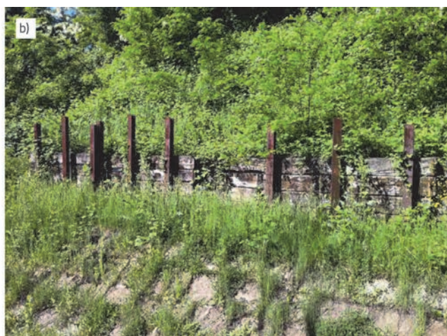
Slika 1. Sanacija klizanja tla: a) montažnim betonskim zidom; b) zidom od zabijenih tračnica i drvenih pragova
