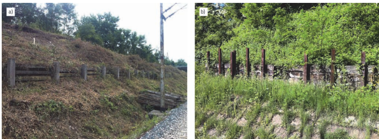
Slika 1. Sanacija klizanja tla: a) montažnim betonskim zidom; b) zidom od zabijenih tračnica i drvenih pragova
