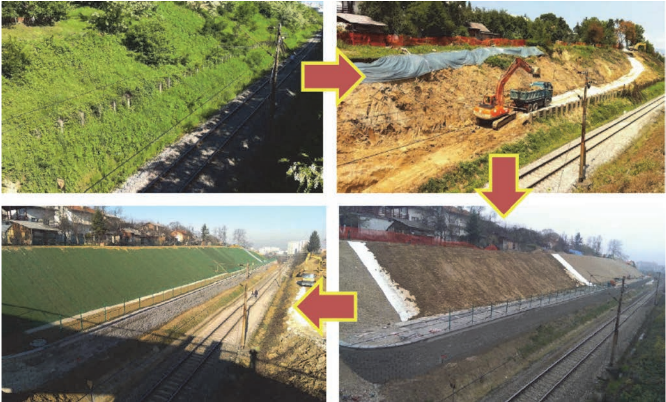
Slika 9. Izvedba sanacije klizišta na dionici A
