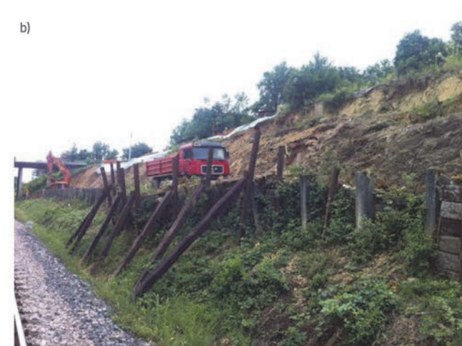
Slika 2. Deformacija primijenjenih mjera sanacije pokosa: a) deformiran montažni betonski zid; b) improvizirane mjere zaštite pokosa
