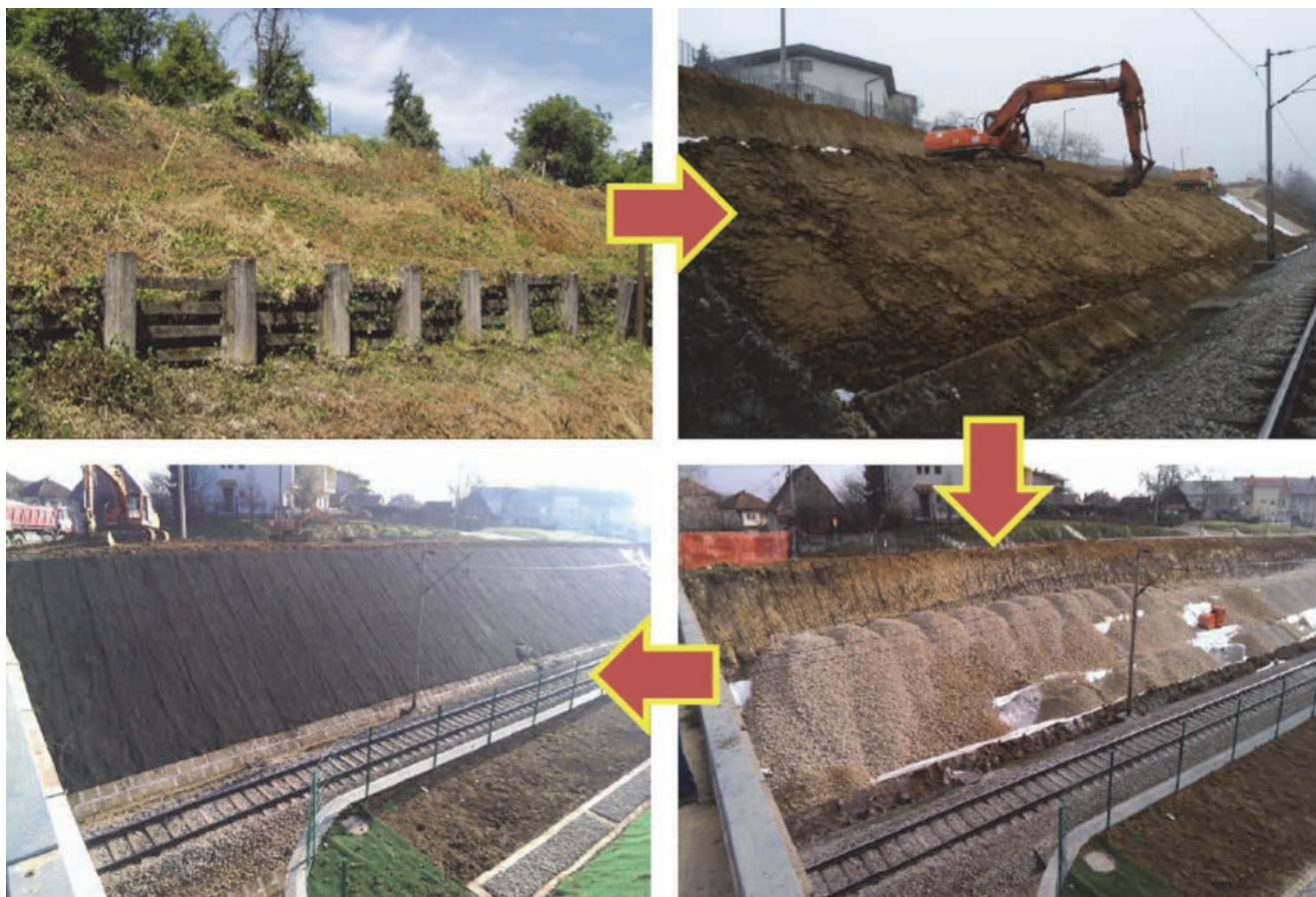
Slika 10. Izvedba sanacije klizišta na dionici D
