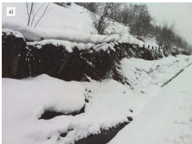
Slika 2. Deformacija primijenjenih mjera sanacije pokosa: a) deformiran montažni betonski zid; b) improvizirane mjere zaštite pokosa
