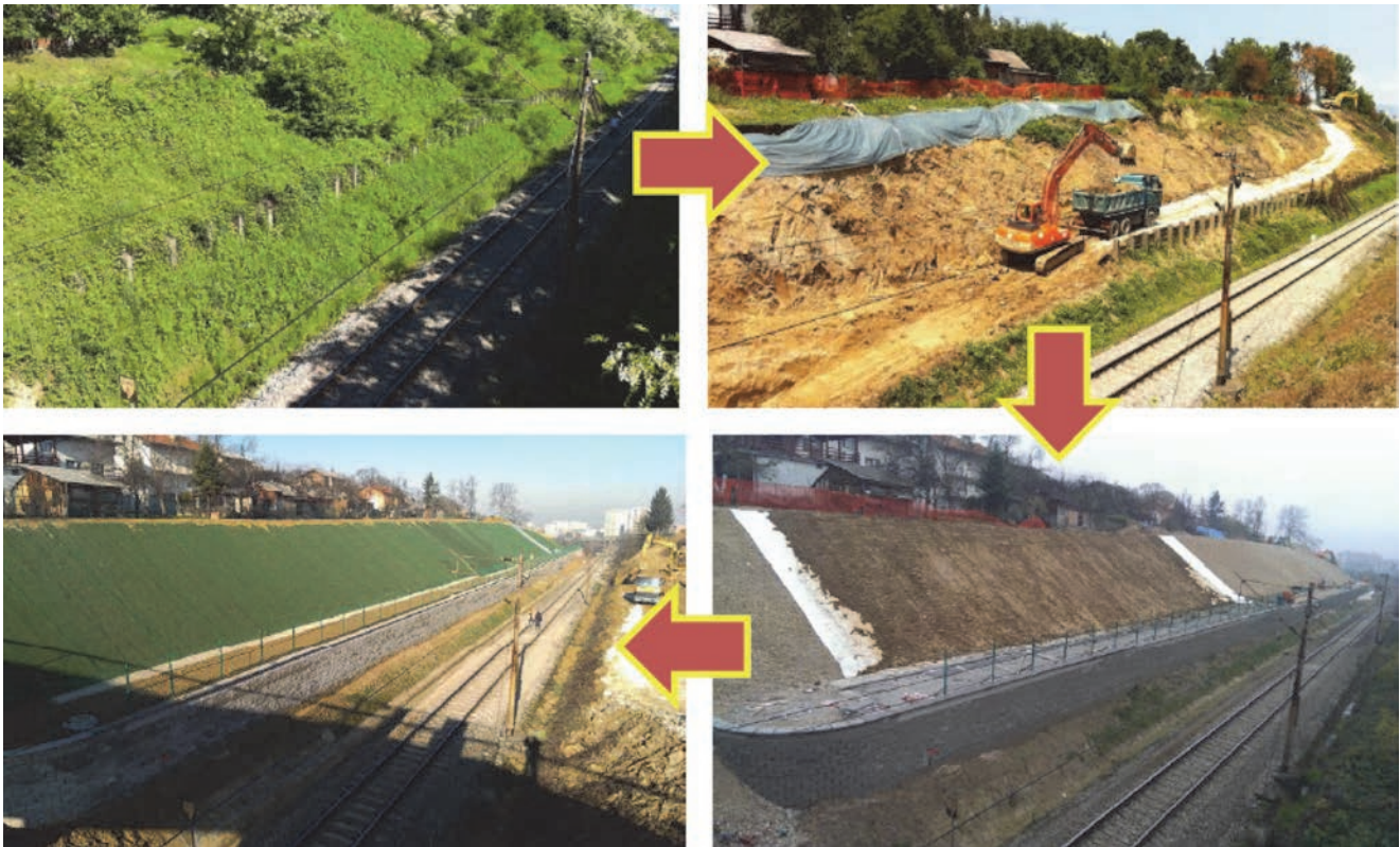
Slika 9. Izvedba sanacije klizišta na dionici A
