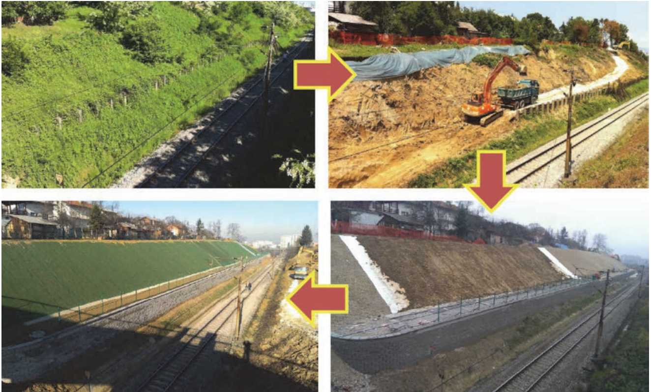
Slika 9. Izvedba sanacije klizišta na dionici A
