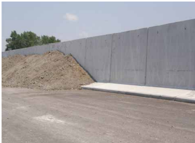
Slika 3. Privremeno odlagalište stabiliziranog i dehidriranog mulja (na lokaciji uređaja)
