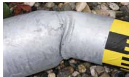
Slika 7. Detalj stupa nakon pada na tlo [6]
