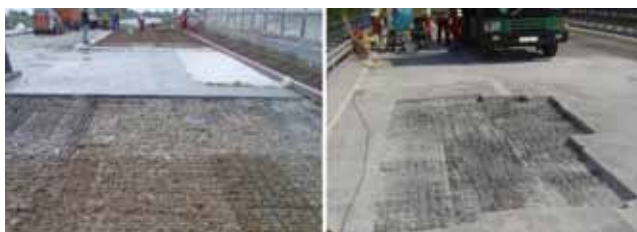
Slika 1. Zamjena horizontalnih slojeva za popravak kolničke ploče mostova
