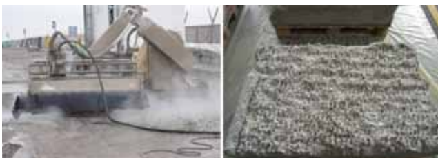
Slika 2. Obrada vodom pod visokim tlakom (hidrodemoliranje) gornje površine betona blokova A i B
