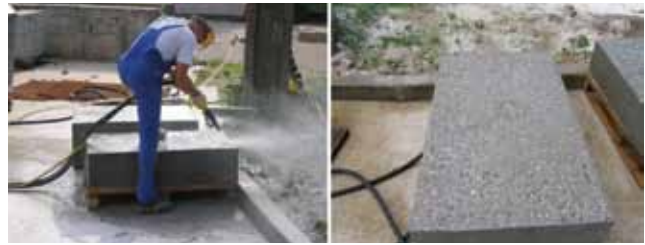
Slika 4. Obrada mlazom vode s pijeskom (pjeskarenje) gornje površine betona blokova A i B
