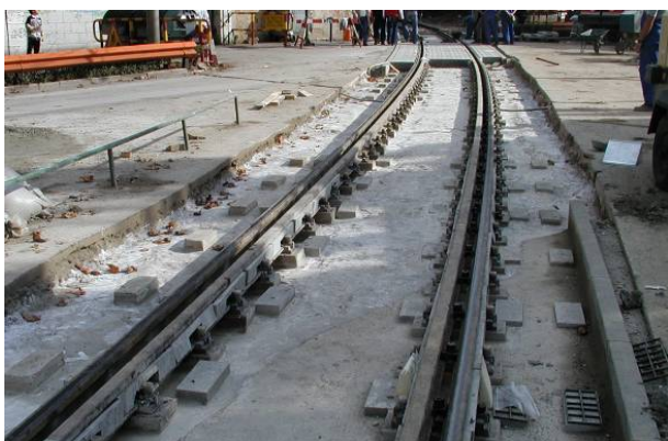
Slika 24. Izgradnja željezničkog kolosijeka u Rijeci (2002.)
