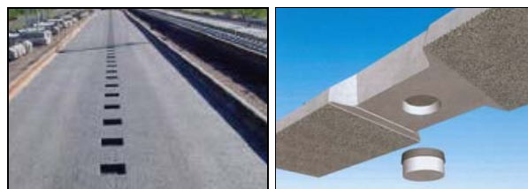
Slika 13. Utori u asfaltnom sloju za ugradnju sidrenog bloka
