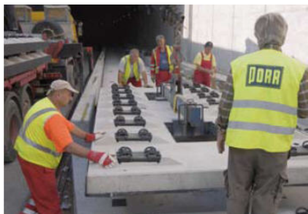
Slika 16. Montaža pločastog kolosijeka tipa "ÖBB-PORR"
