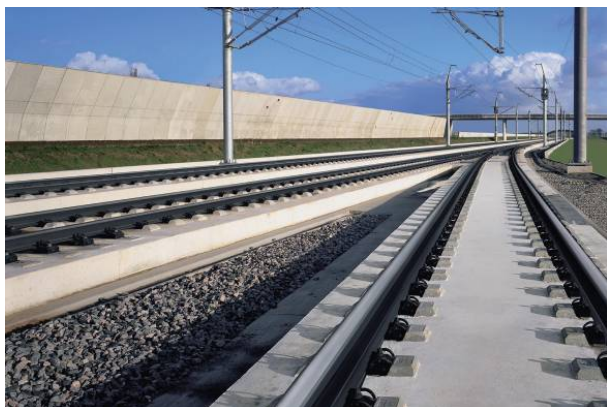
Slika 2. Kolosijek na čvrstoj podlozi (bez zastora)
