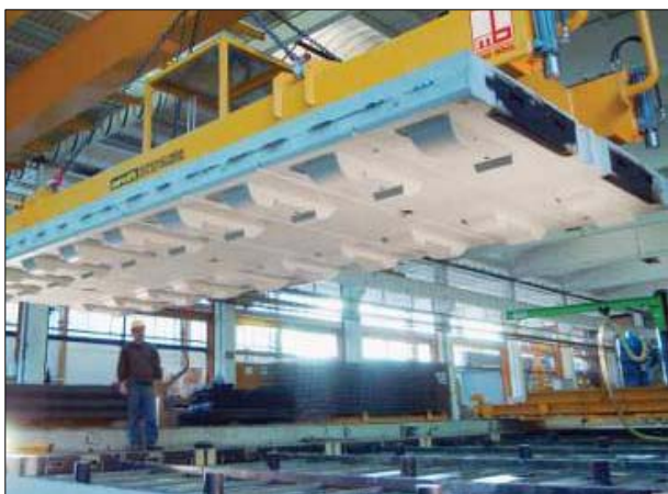
Slika 15. Tvornička proizvodnja predgotovljenih ploča [13]
