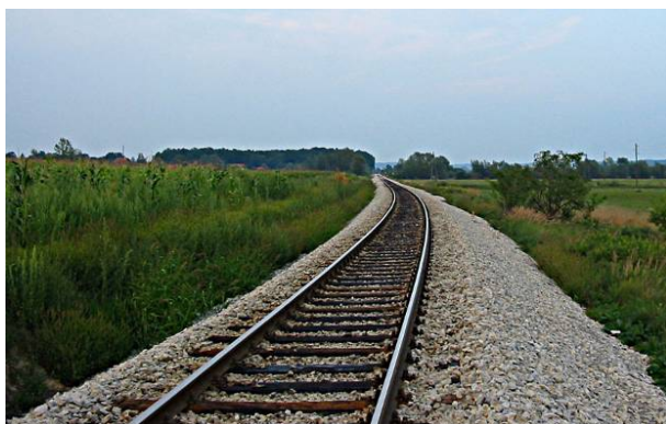
Slika 1. Klasična kolosiječna konstrukcija (sa zastornom prizmom)
