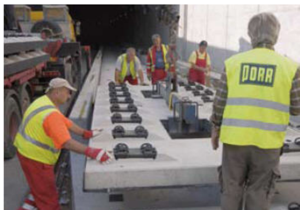
Slika 16. Montaža pločastog kolosijeka tipa "ÖBB-PORR"
