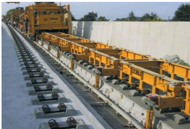
Slika 11. Ugradnja pragova u neočvrstnuli beton kod sustava „Züblin“
