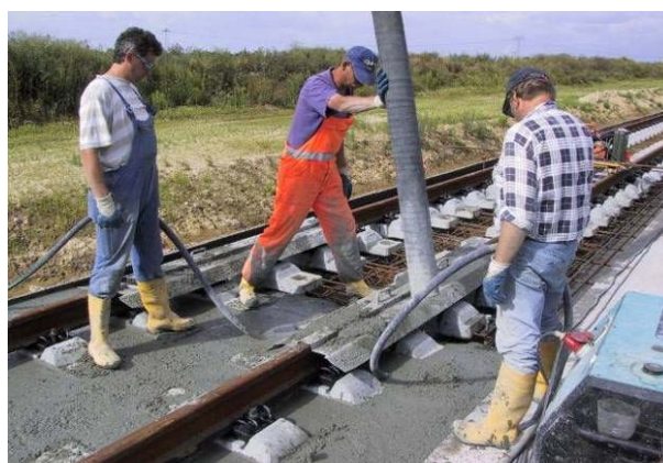
Slika 10. Ugradnja betona u kolosijek kod sustava „Rheda“ [10]
