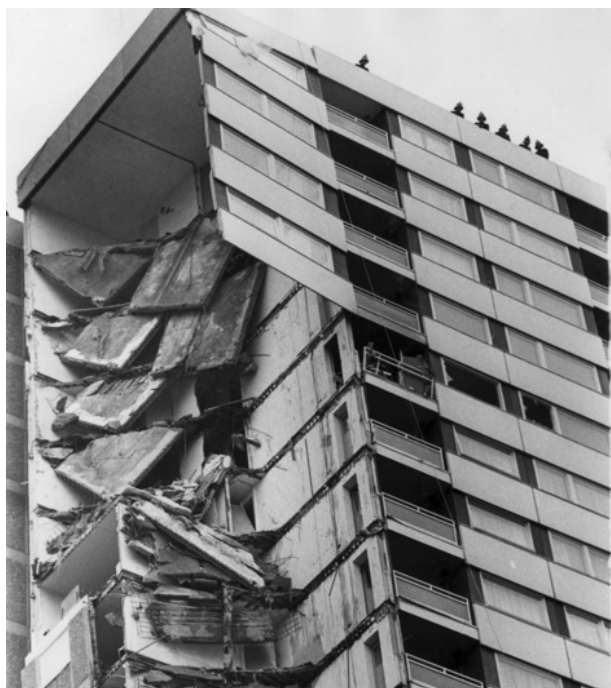
Slika 1. Urušavanje zgrade Ronan Point
