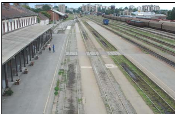
Slika 4. Kolodvor u Osijeku
