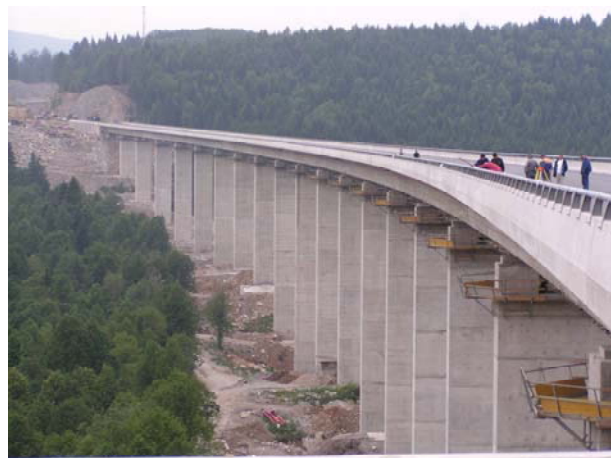
Slika 10. Most Zečeve drage u izgradnji
