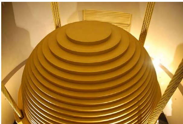
Slika 9. Uređaj s usklađenom masom (neboder Taipei)
