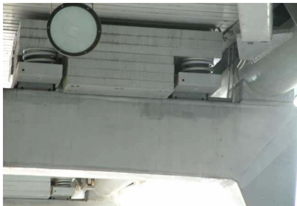
Slika 7. Primjer samocentrirajućeg uređaja
