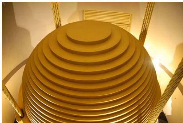
Slika 9. Uređaj s usklađenom masom (neboder Taipei)
