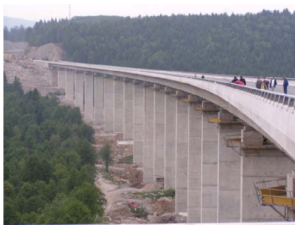
Slika 10. Most Zečeve drage u izgradnji
