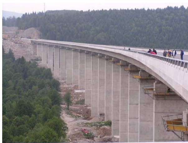
Slika 10. Most Zečeve drage u izgradnji
