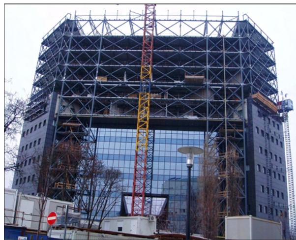
Slika 16. Dio nadogradnje sa samostalnim stupovima
