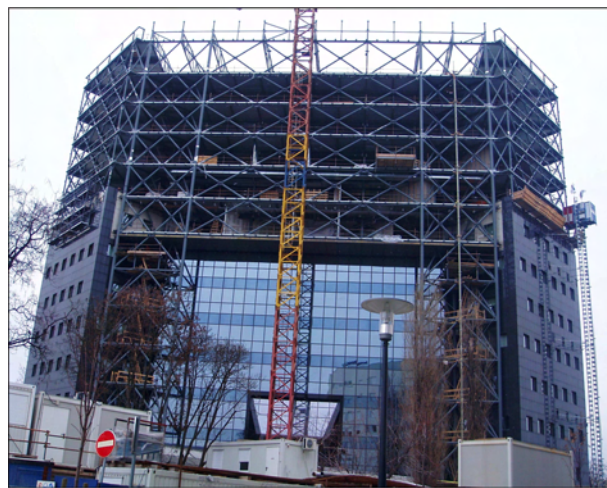
Slika 16. Dio nadogradnje sa samostalnim stupovima
