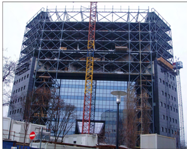
Slika 16. Dio nadogradnje sa samostalnim stupovima
