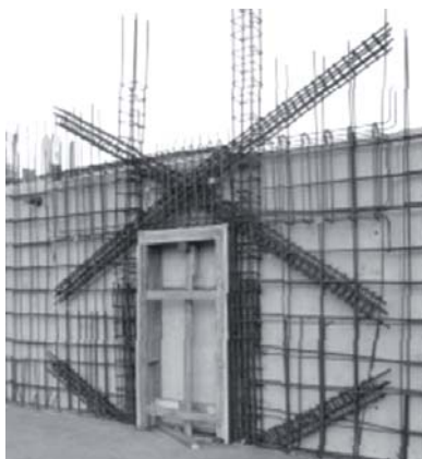
Slika 14. Armatura vezne grede povezanih zidova [9]
