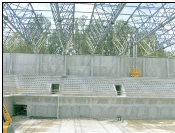
Slika 15. Krovni nosači u izvedbi
