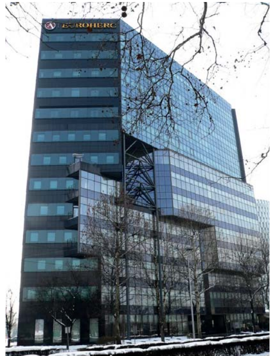
Slika 16. Poslovna zgrada Euroherc osiguranja nakon nadogradnje
