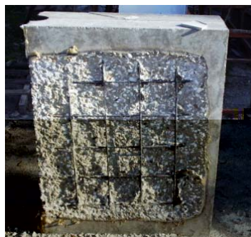
Slika 15. Izgled armiranobetonskog elementa nakon eksplozivnog pucanja [41]
