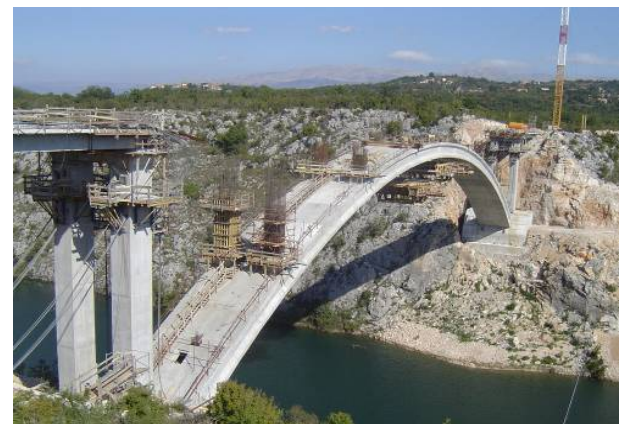
Slika 18. Mostovi s ugrađenim sensorima za korozijsko praćenje: most Krka (gore); most preko rijeke Cetine (dolje)
