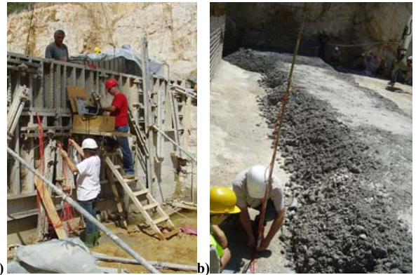
Slika 9. Mjerenje razvoja temperature tijekom betoniranja
