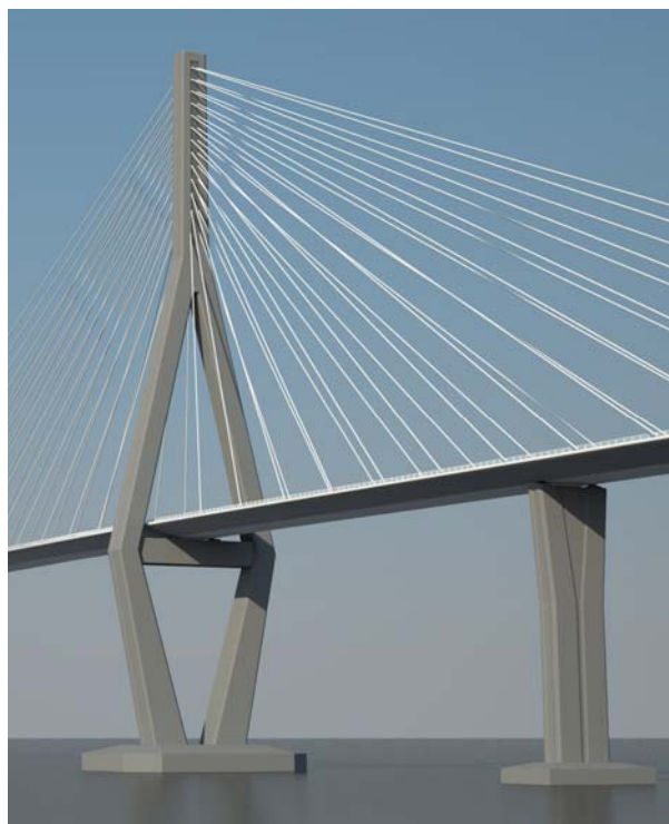
Slika 15. Vizualizacija mosta - pylon i stup
