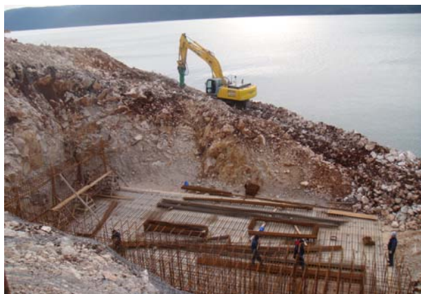
Slika 14. Gradnja mosta Pelješac - temelj stupa S2
