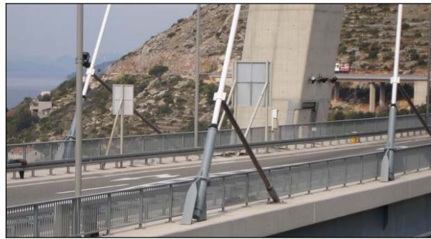
Slika 13. Ugrađeni prigušivači
