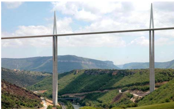
Slika 24. Viadukt Millau, dolina Tarn
