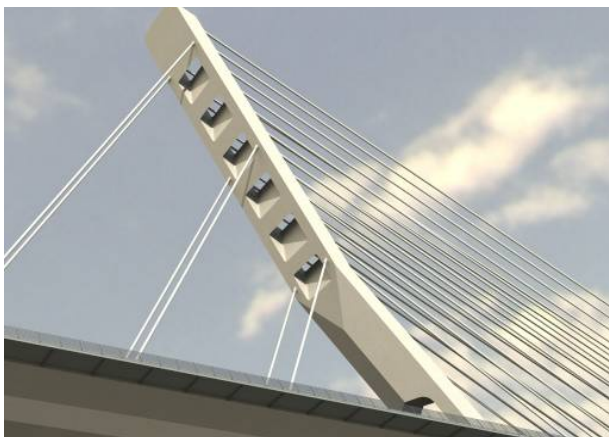
Slika 4. Pogled na pylon mosta Jarun
