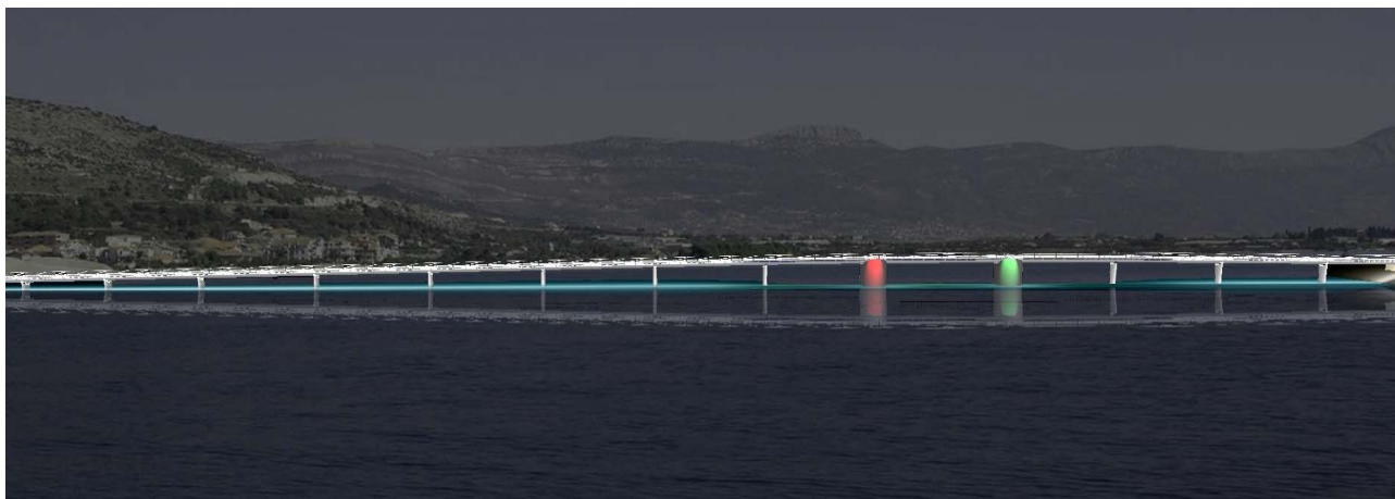
Slika 14. Dekorativna rasvjeta mosta
