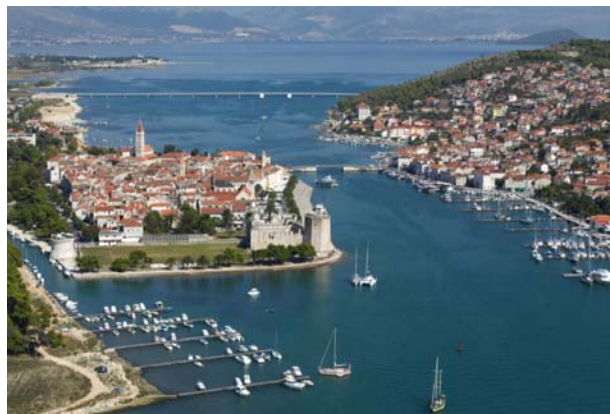
Slika 3. Grad Trogir s novim mostom na Čiovo u pozadini
