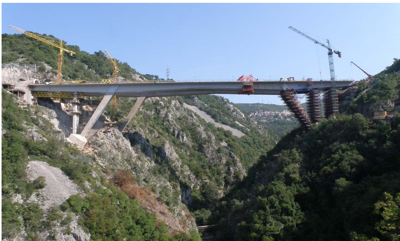
Slika 14. Pogled na mostove preko Rječine na riječkoj obilaznici
