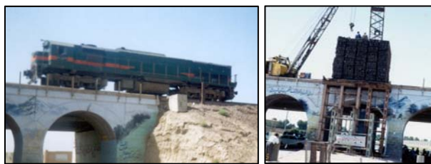
Slika 6. Dinamičko i statičko ispitivanje jednoga staroga željezničkog mosta
