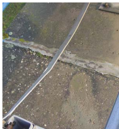
Slika 31. Dotrajala masa za fugiranje reški
