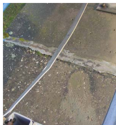
Slika 31. Dotrajala masa za fugiranje reški
