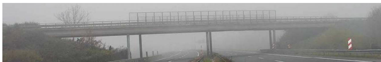
Slika 8. Pogled na pregledani nadvožnjak kod Popovače
