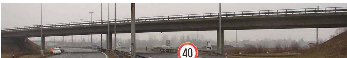
Slika 5. Pogled na jedan od pregledanih nadvožnjaka tipa PK
