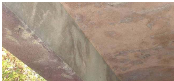
Slika 18. Procjeđivanje i kristalizacija na spojevima ploče s nosačima nadvožnjaka tipa IN
