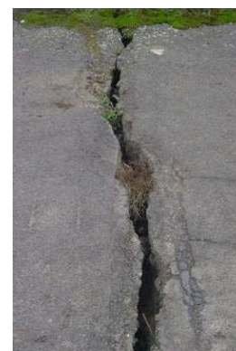
Slika 30. Poprečna reška iznad oslonca nadvožnjaka tipa SO
