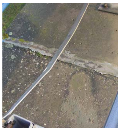
Slika 31. Dotrajala masa za fugiranje reški
