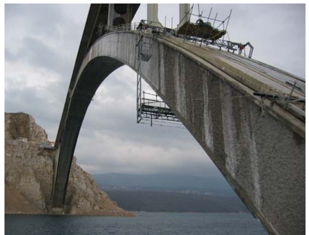
Slika 2. Sanacija maloga luka Krčkoga mosta
