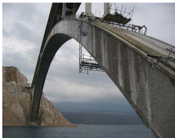
Slika 2. Sanacija maloga luka Krčkoga mosta
