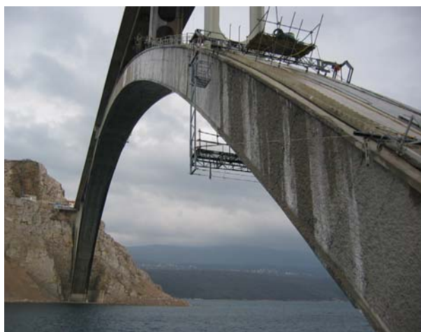
Slika 2. Sanacija maloga luka Krčkoga mosta
