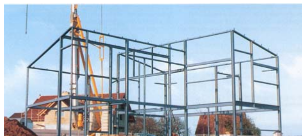
Slika 6. Okvirni sustav građenja čelikom
