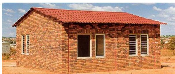
Slika 18. Primjer kuće jednostavne montaže
