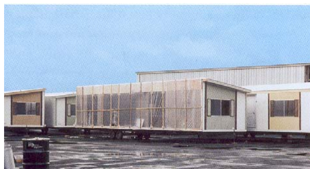
Slika 2. Pokretne kuće izvedene u modulima čeličnih okvira
