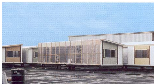
Slika 2. Pokretne kuće izvedene u modulima čeličnih okvira
