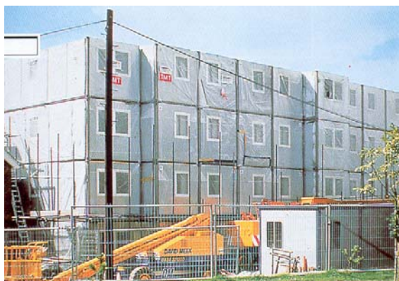
Slika 23. Montaža modula
