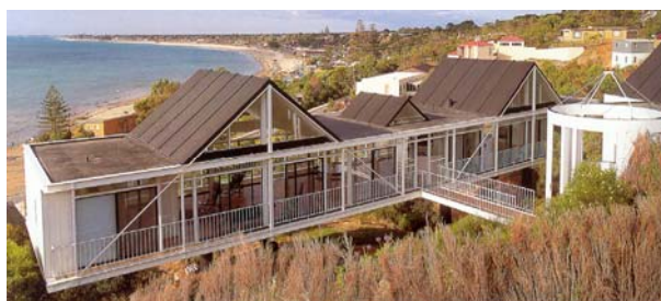
Slika 21. Izgled dogotovljene kuće
