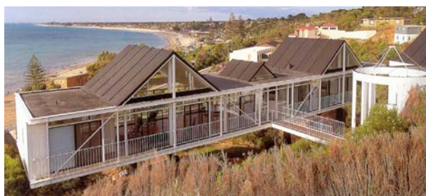
Slika 21. Izgled dogotovljene kuće
