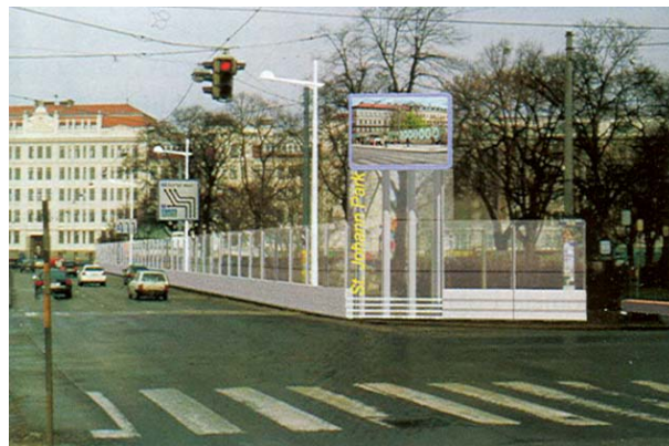
Slika 9. Prozirna barijera za zaštitu od buke [20]
