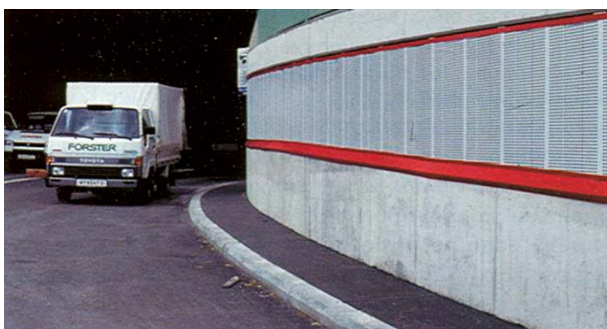
Slika 8. Oblaganje zidova podvožnjaka apsorberajućim panelima [19]
