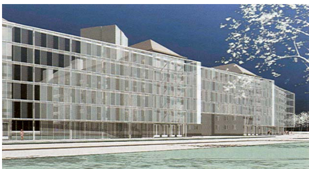
Slika 7. Prozirna barijera za zaštitu od buke (Beč) [1]
