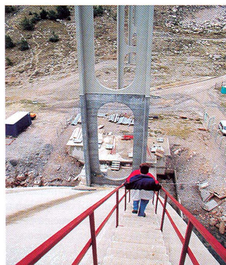
Slika 11. Stup S27 Krčkog mosta ojačan i zaštićen u podnožju mikroarmiranim betonom MB 75
