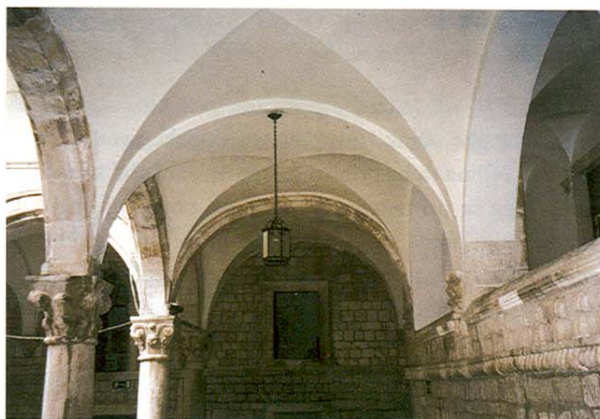
Slika 5. Svodovi prizemlja na južnoj strani atrija
