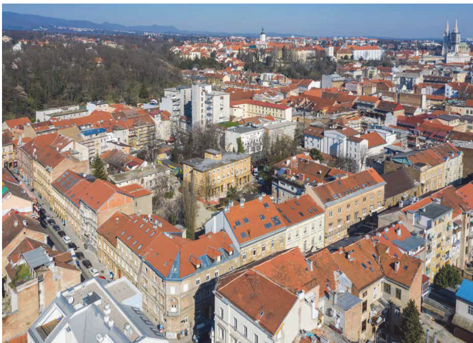
Slika 1. Pogled na Blok 19 s jugozapada: ugao Dalmatinske i Medulićeve ulice [2]
