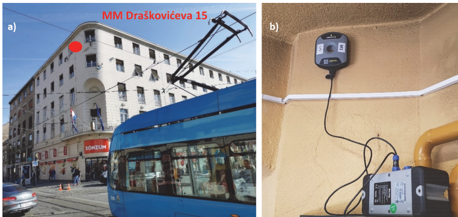
Slika 3. Mjerna lokacija na 4. katu zgrade (Draškovićeve 15) (a), mjerni uređaj "SWARM" (b)
