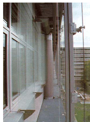
Slika 4. Prikaz dvostrukoga pročelja iznutra
