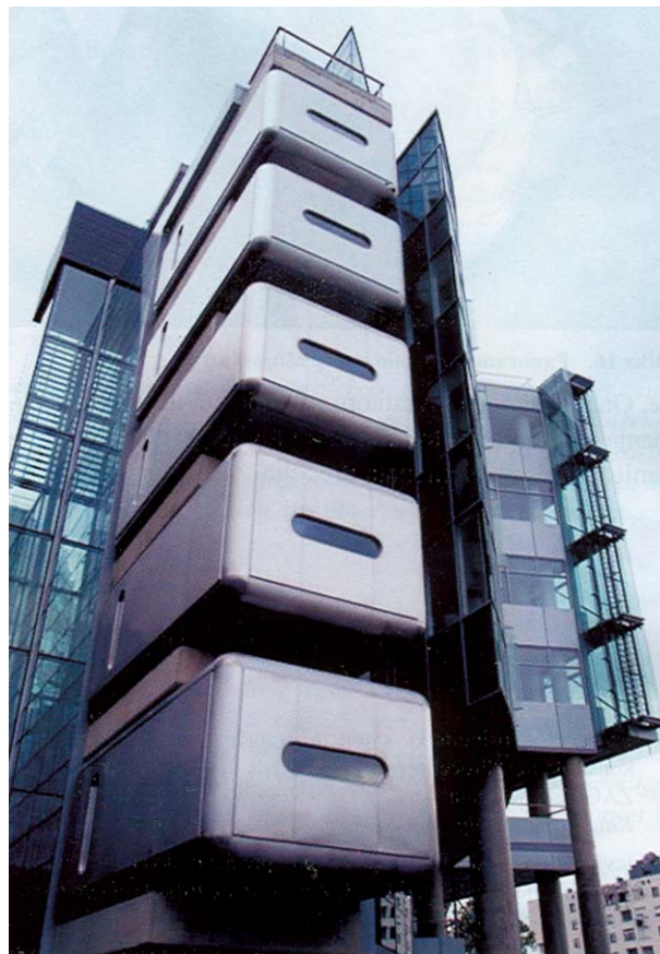
Slika 15. Pogled na modularne sanitarne jedinice
