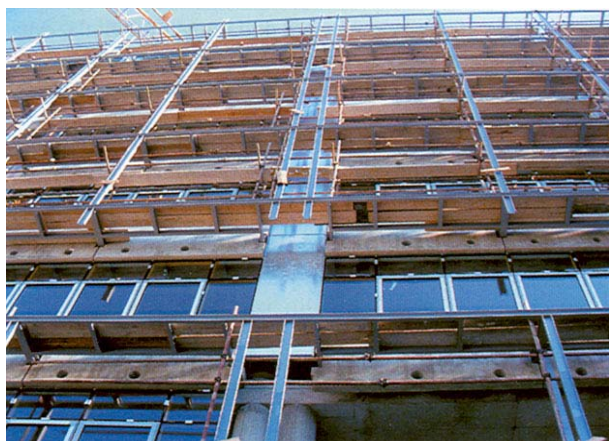
Slika 5. Montaža čelične potkonstrukcije na južnom pročelju ('A', 'A1', 'B' i 'B1')
