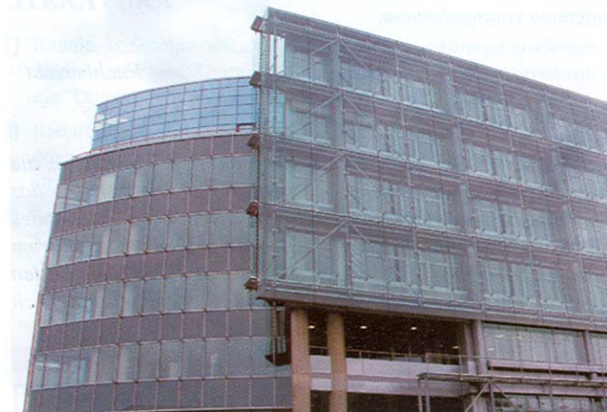
Slika 2. Pogled sa sjeverozapada
