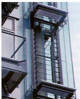
Slika 10. Detalj pokretnih krilaca dvostrukog pročelja
