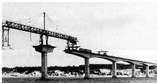
Slika 1. Konzolna montaža predgotovljenih odsječaka mosta Sallingsund
