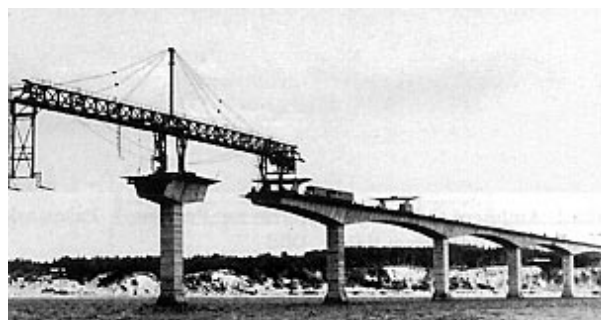
Slika 1. Konzolna montaža predgotovljenih odsječaka mosta Sallingsund
