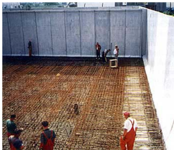
Slika 6. Izvedba podne ploče u sabirno-aeracijskom bazenu
