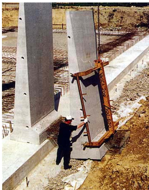
Slika 2. Zidni paneli tijekom montaže
