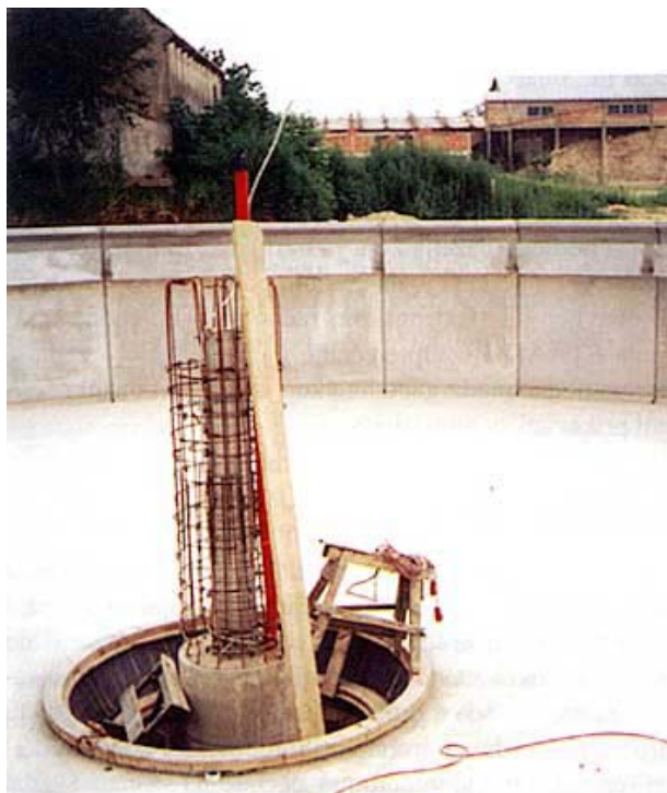
Slika 4. Detalj taložnika tijekom gradnje
