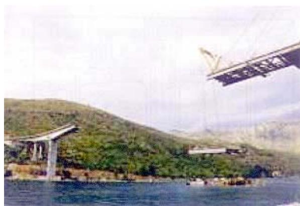
Slika 18. Podizanje sekcije čeličnog sklopa s maone derrick kranom
