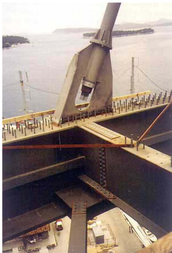
Slika 4. Detalj glavnog i poprečnog nosača uz pričvršćenje kose zatege, prije izvedbe ploče
