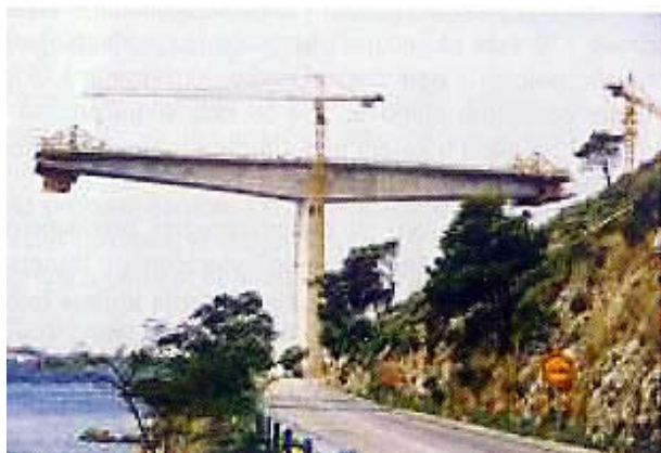
Slika 16. Konzolna gradnja prednapetog sklopa
