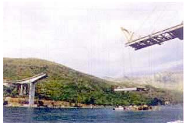
Slika 18. Podizanje sekcije čeličnog sklopa s maone derrick kranom
