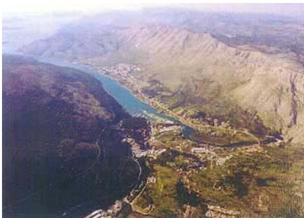
Slika 1. Panorama zaljeva Rijeke Dubrovačke prije izgradnje mosta
