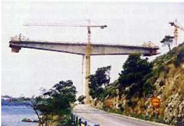
Slika 16. Konzolna gradnja prednapetog sklopa
